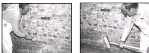
Рисунок 8 - Удаление непрочных участков в гидроизолируемой поверхности.
