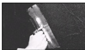
Рисунок 13 - Нанесение третьего слоя гидроизоляции.
