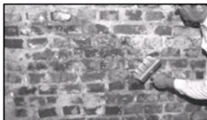
Рисунок 10 - Нанесение грунтовки с помощью кисти.
